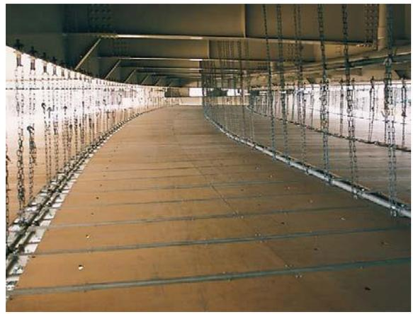
可鋪設塑膠帆布回收除鏽污水及工程廢棄物，不造成環境污染
