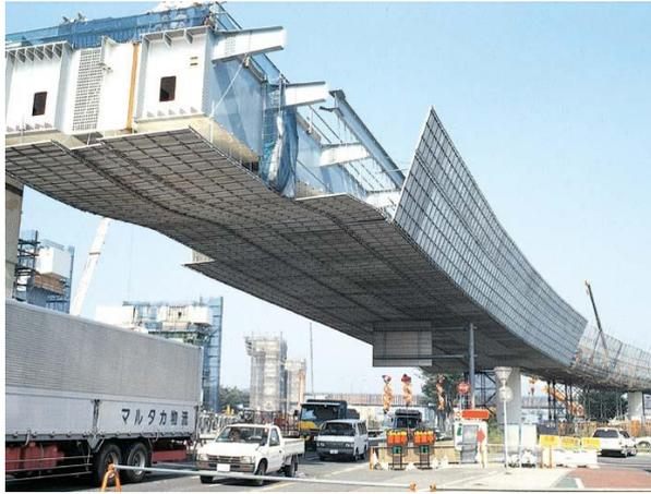
懸吊式施工法將須維修保養部份搭設夾層空間，提供後續維修保養所需之工作空間
