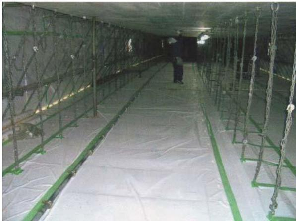
挑高建物的照明部份可採網狀架板再覆蓋透明壓克力板，不影響採光
